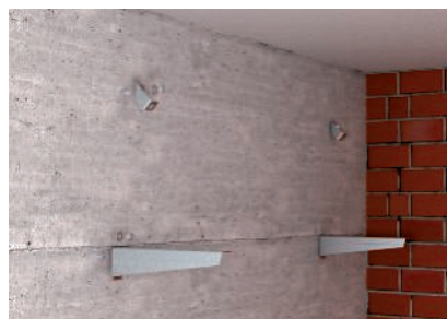
A konzol és a srég csatlakozó alkatrészek falra történő szerelése.
