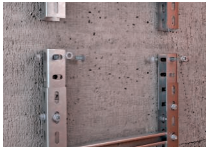
Toldáspont csavarozott összekötővel.
