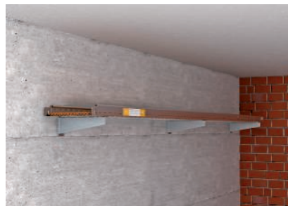
Vezetékek rögzítése oldalfalra.
