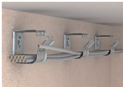
A kábelek egyszerű behelyezése a nyitott bilincsekbe.
