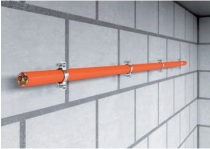
A kábelek vízszintes szerelése a falon.
