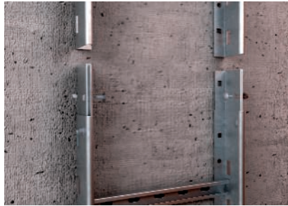
Toldás kialakítás csavarozott hosszoldóval.
