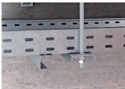
Függőleges menetes száras rögzítése a legalsó kábeltálcára.
