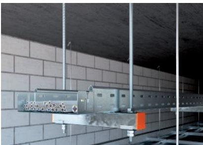
Egyszintes mennyezeti szerelés tűzvédelmi álmennyezet felett.
