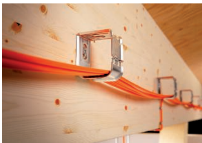
Kábelhelyezés kábelköteg-rögzítővel a fagerenda oldalán.
