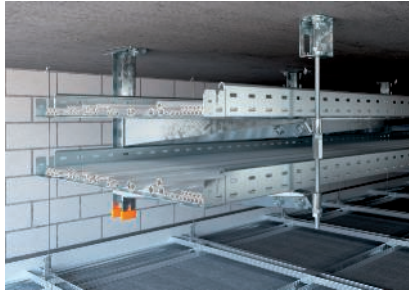
Kétszintes födémfüggesztés, egy oldalon elhelyezett konzollokkal.
