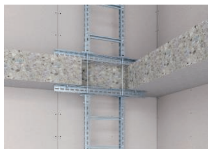
A kábelhágcsók felszerelése közvetlenül a mennyezeti nyílás alá keresztprofilokkal és fejlemezekkel.
