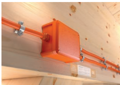
OBO FireBox szerelése fagerendán.
