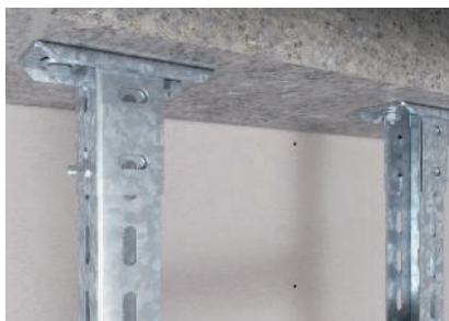
Az oldalprofil mennyezeti rögzítése csavarozott fejlemezekkel.
