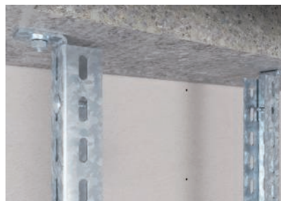
Az oldalprofil mennyezeti rögzítése szerelőszeglettel.
