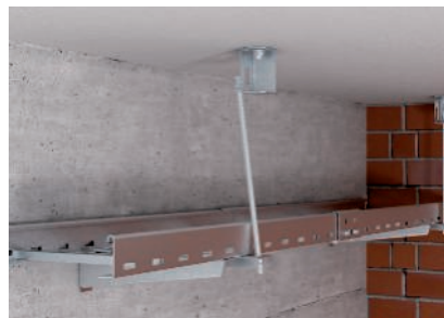
A menetes rúd rögzítése a tűzvédelmi kennyellel.
