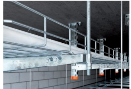
Csavarmentes toldásponti összekötés.
