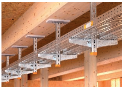
Függesztett oszlop szerelése a fagerendán, tűzvédelmi alátét-lappal.
