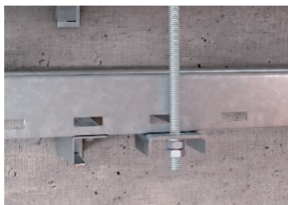
A függőleges menetes rúd rögzítése a csatlakozóelemhezl.
