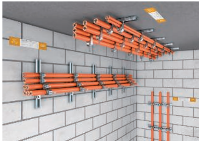
A kábelek vízszintes szerelése a födémen a kengyeles bilincsekkel.
