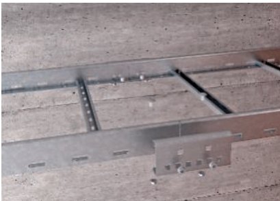
A hosszitoldó szerelése félgömbfejű csavarokkal.
