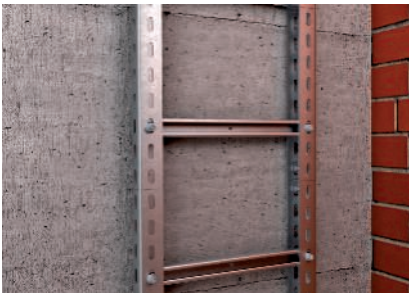
A kábelhágcsó közvetlen rögzítése a tömör falra.
