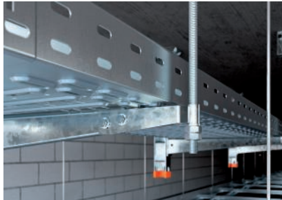
Menetes rudak szerelése a konzolok csúcsánál elhelyezett csatlakozó szeglettel.
